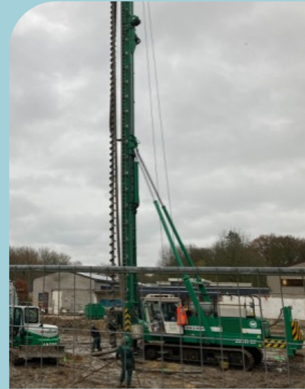
Plaatsing fundering met behulp van de grootste boorstelling van Nederland.
